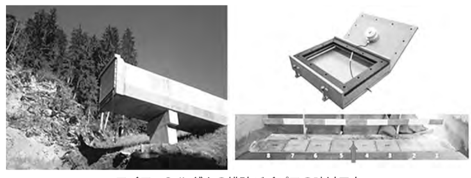
スイス・Solisダムの排砂バイパスの吐け口と設置されているジオフォン
