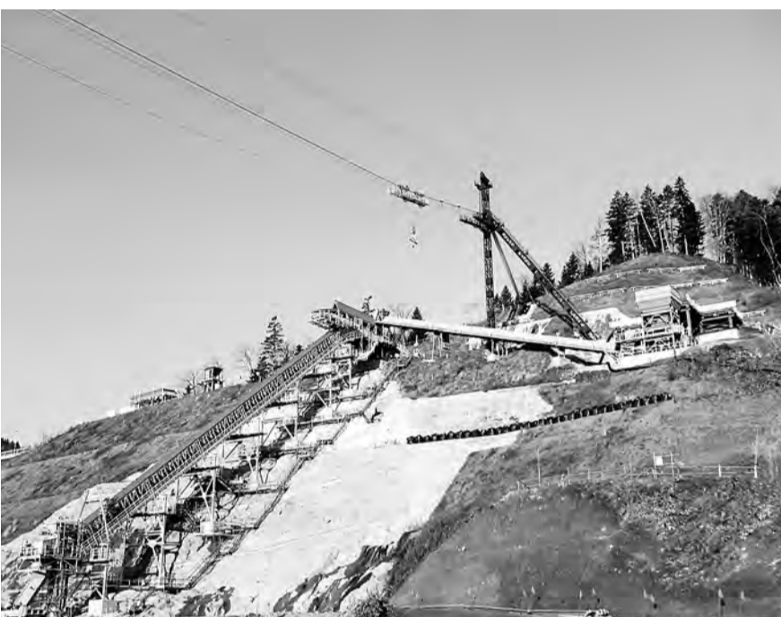
堤体右岸に配置した急傾斜サンドイッチベルトコンベヤー
