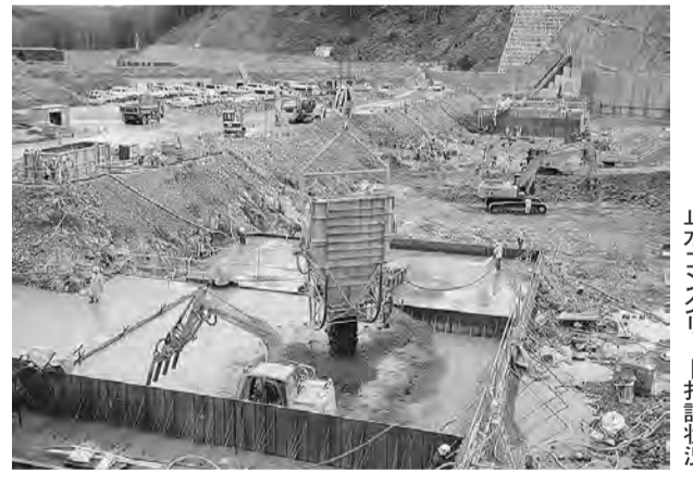
止水コンクリート打設状況
