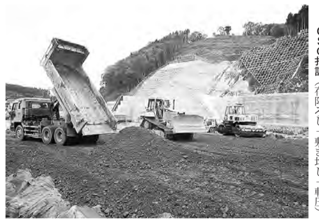
CSG打設(荷降ろし+敷き均し+転圧)
