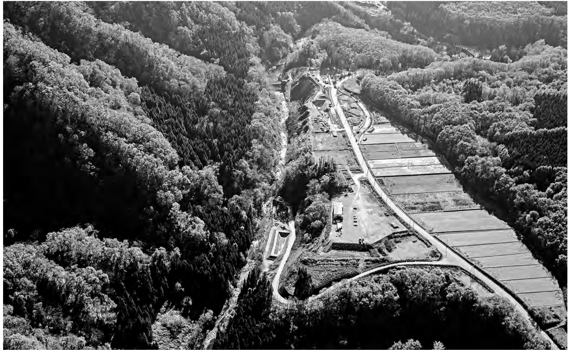
建設が進む最上小国川流水型ダム
