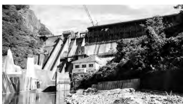
作業中の笠堀ダム
