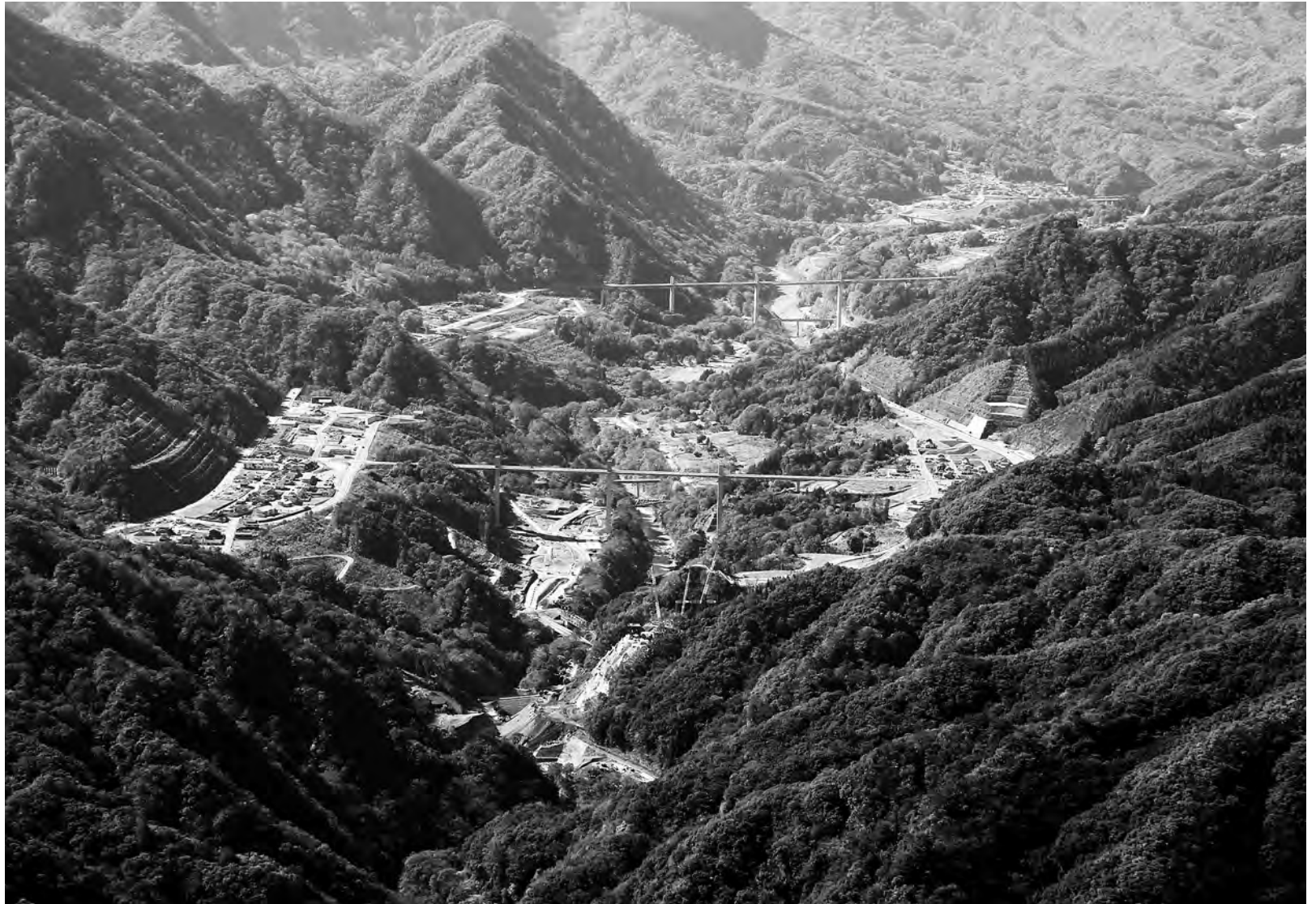
ダム建設地全景(10月26日撮影)
