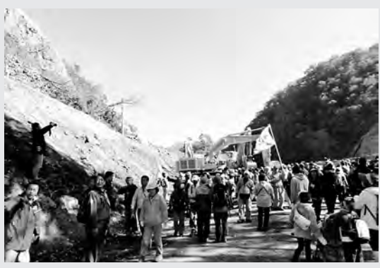
やんばウォーク(10月25日)。多くの参加者が本体建設工事の現場を体感
