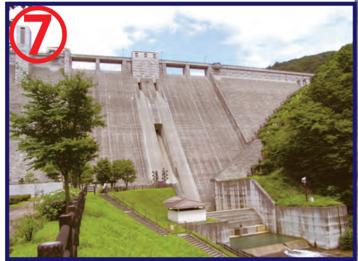
① 四方川ダム ② 重力式コンクリートダム ③ 89.5m/330m/516,000m 3 ④ 群馬県 ⑤ 1999年 ① Shimigawa Dam ② Concrete Gravity Dam ③ 89.5m/330m/516,000m 3 ④ Gunma Prefecture ⑤ 1999
