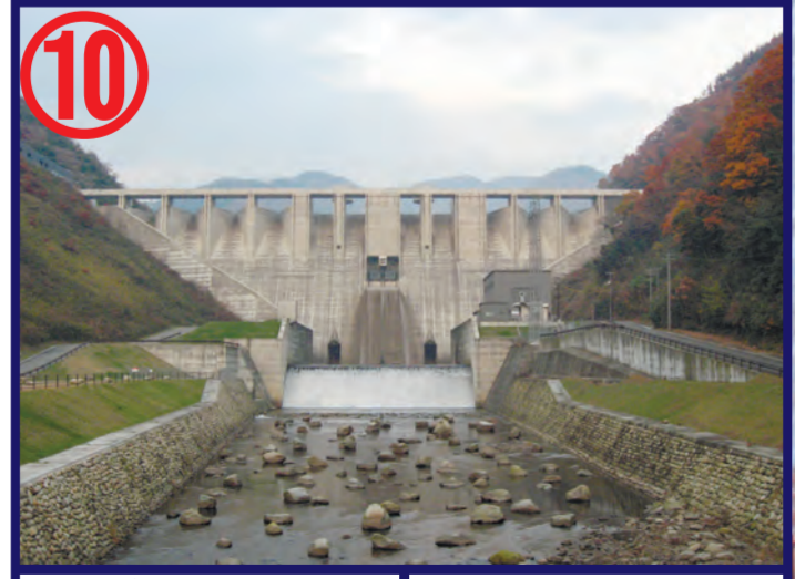
① 沼田ダム ② 重力式コンクリートダム ③ 74m/225m/300,000m 3 ④ 中国地方整備局 ⑤ 2004年 ① Tomata Dam ② Concrete Gravity Dam ③ 74m/225m/300,000m 3 ④ Chugoku Regional Development Bureau ⑤ 2004
