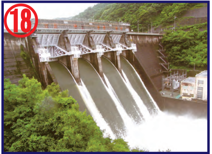
① 鹿野川ダム ② 重力式コンクリートダム ③ 61m/167.9m/161,000m 3 ④ 西国地方整備局 ⑤ 1958年/2017年(再開発) ① Kanogawa Dam ② Concrete Gravity Dam ③ 61m/167.9m/161,000m 3 ④ Shikoku Regional Development Bureau ⑤ 1958/2017 (Redevelopment)
