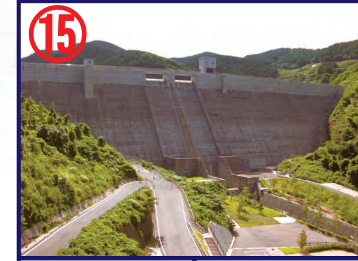
① 笛吹ダム ② 重力式コンクリートダム ③ 59.8m/296.5m/231,000m 3 ④ 長崎県 ⑤ 2006年 ① Fuefuki Dam ② Concrete Gravity Dam ③ 59.8m/296.5m/231,000m 3 ④ Nagasaki Prefecture ⑤ 2006
