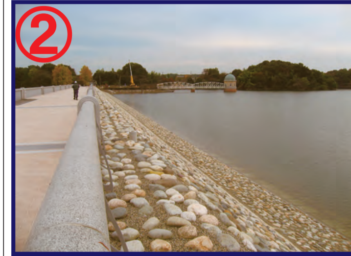
① 村山下アースダム ② 32.6m/610m/1,100,000m 3 ③ 東京都水道局 ④ 1927年/2008年(耐震強化) ① Murayamashimo Dam ② Earth Dam ③ 32.6m/610m/1,100,000m 3 ④ Bureau of Waterworks Tokyo Metropolitan Government ⑤ 1927/2008 (Seismic Strengthening)
