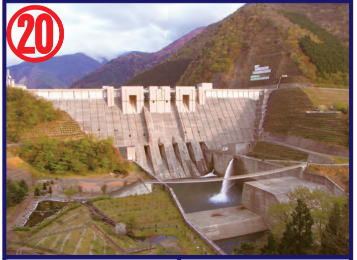
① 長島ダム ② 重力式コンクリートダム ③ 109m/308m/861,000m 3 ④ 中部地方整備局 ⑤ 2001年 ① Nagashima Dam ② Concrete Gravity Dam ③ 109m/308m/861,000m 3 ④ Chubu Regional Bureau ⑤ 2001
