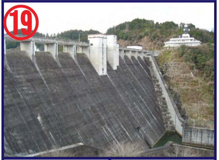
① 布目ダム ② 重力式コンクリートダム ③ 72m/322m/331,000m 3 ④ 水資源機構 ⑤ 1991年 ① Nunome Dam ② Concrete Gravity Dam ③ 72m/322m/331,000m 3 ④ Japan Water Agency ⑤ 1991
