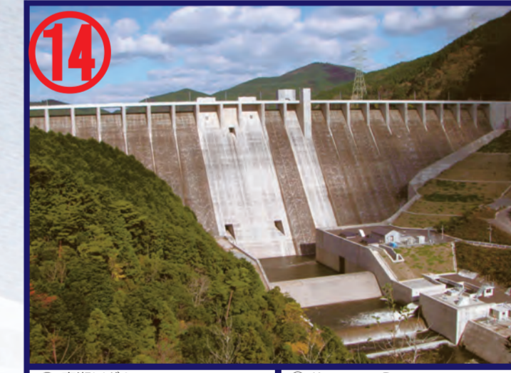
① 高瀬川ダム ② 重力式コンクリートダム ③ 97m/454.5m/941,000m 3 ④ 九州地方整備局 ⑤ 2011年 ① Kasegawa Dam ② Concrete Gravity Dam ③ 97m/454.5m/941,000m 3 ④ Kyushu Regional Development Bureau ⑤ 2011
