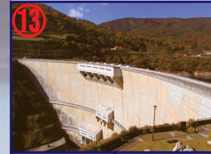
① 温井ダム ② アーチダム ③ 156m/382m/810,000m 3 ④ 中国地方整備局 ⑤ 2001年 ① Nukui Dam ② Arch Dam ③ 156m/382m/810,000m 3 ④ Chugoku Regional Development Bureau ⑤ 2001
