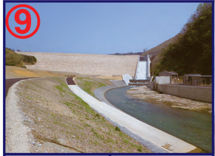
① 殿ダム ② ロックフィルダム ③ 75m/294m/2,060,000m 3 ④ 中国地方整備局 ⑤ 2011年 ① Tono Dam ② Rockfill Dam ③ 75m/294m/2,060,000m 3 ④ Chugoku Regional Development Bureau ⑤ 2011
