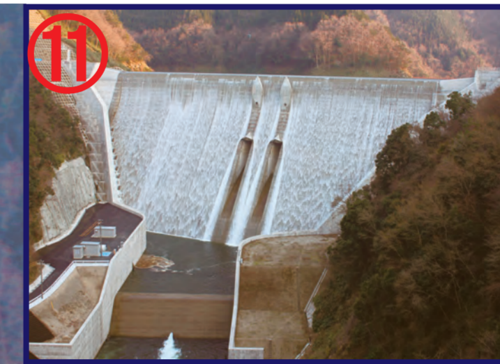
① 志津見ダム ② 重力式コンクリートダム ③ 81m/266m/416,000m 3 ④ 中国地方整備局 ⑤ 2010年 ① Shitsumi Dam ② Concrete Gravity Dam ③ 81m/266m/416,000m 3 ④ Chugoku Regional Development Bureau ⑤ 2010
