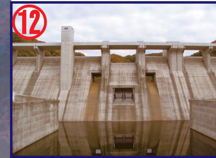
① 灰塚ダム ② 重力式コンクリートダム ③ 50m/196.6m/164,000m 3 ④ 中国地方整備局 ⑤ 2006年 ① Haizuka Dam ② Concrete Gravity Dam ③ 50m/196.6m/164,000m 3 ④ Chugoku Regional Development Bureau ⑤ 2006
