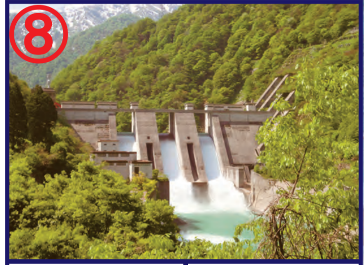
① 宇奈月ダム ② 重力式コンクリートダム ③ 97m/190m/510,000m 3 ④ 北陸地方整備局 ⑤ 2000年 ① Unazuki Dam ② Concrete Gravity Dam ③ 97m/190m/510,000m 3 ④ Hokuriku Regional Development Bureau ⑤ 2000
