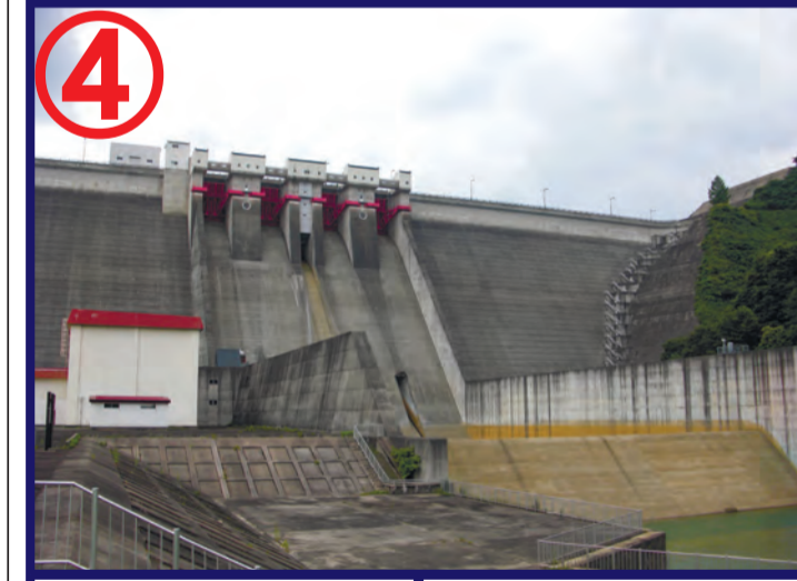
① 玉川ダム ② 重力式コンクリートダム ③ 100m/441.5m/1,150,000m 3 ④ 東北地方整備局 ⑤ 1990年 ① Tamagwa Dam ② Concrete Gravity Dam ③ 100m/441.5m/1,150,000m 3 ④ Tohoku Regional Bureau ⑤ 1990
