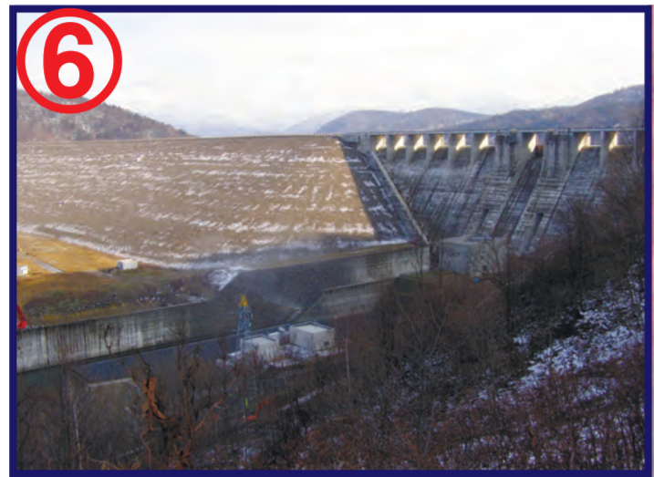
① 忠別ダム ② 重力式コンクリートダム・ロックフィルダム複合 ③ 86m/885m/9,444,000m 3 ④ 北海道開発局 ⑤ 2006年 ① Chubetsu Dam ② Concrete Gravity Dam and Rockfill Dam ③ 86m/885m/9,444,000m 3 ④ Hokkaido Development Bureau ⑤ 2006
