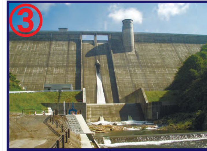
① 鷹生ダム ② 重力式コンクリートダム ③ 77m/322m/328,000m 3 ④ 岩手県 ⑤ 2006年 ① Takou Dam ② Concrete Gravity Dam ③ 77m/322m/328,000m 3 ④ Iwate Prefecture ⑤ 2006
