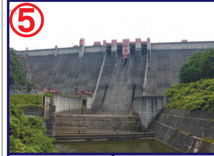
① 浅瀬石川ダム ② 重力式コンクリートダム ③ 91m/330m/700,000m 3 ④ 東北地方整備局 ⑤ 1988年 ① Aseishigawa Dam ② Concrete Gravity Dam ③ 91m/330m/700,000m 3 ④ Tohoku Regional Bureau ⑤ 1988
