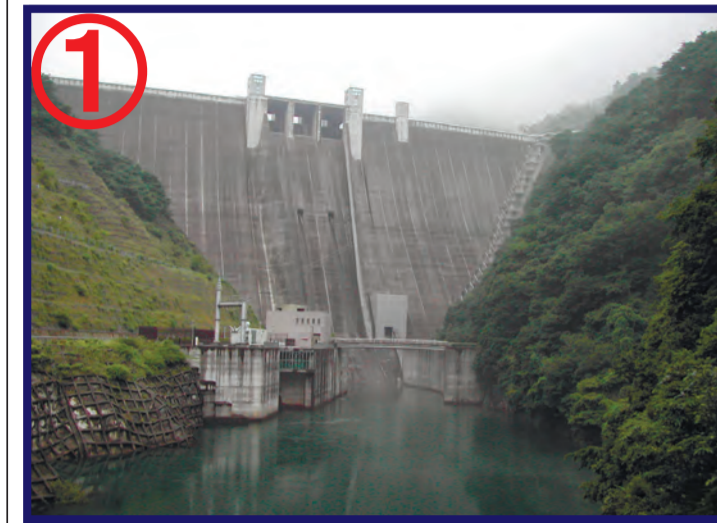
① 宮ヶ瀬ダム ② 重力式コンクリートダム ③ 156m/375m/2,000,000m 3 ④ 関東地方整備局 ⑤ 2000年 ① Miyase Dam ② Concrete Gravity Dam ③ 156m/375m/2,000,000m 3 ④ Kanto Regional Development Bureau ⑤ 2000
