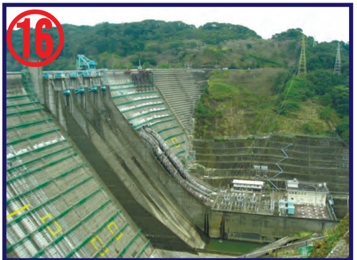
① 鶴田ダム ② 重力コンクリート式ダム ③ 117.5m/450m/1,119,000m 3 ④ 九州地方整備局 ⑤ 1965年/2015年(再開発) ① Tsuruda Dam ② Concrete Gravity Dam ③ 117.5m/450m/1,119,000m 3 ④ Kyushu Regional Development Bureau ⑤ 1965/2015 (Redevelopment)
