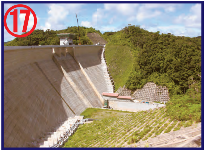
① 大保ダム ② 重力式コンクリートダム ③ 77.5m/363m/400,000m 3 ④ 沖縄総合事務局 ⑤ 2011年 ① Taiho Dam ② Concrete Gravity Dam ③ 77.5m/363m/400,000m 3 ④ Okinawa General Bureau ⑤ 2011
