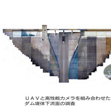
UAVと高性能カメラを組み合わせたダム堤体下流面の調査
