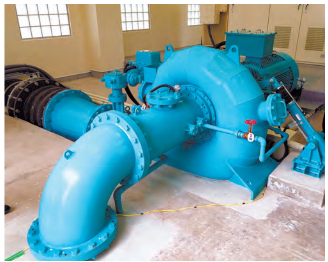
水力発電設備
