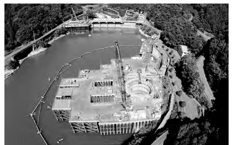
上流構台(リブラス工法)と呑口(径17.5m)全景
