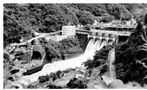
ダム放流時の全景
