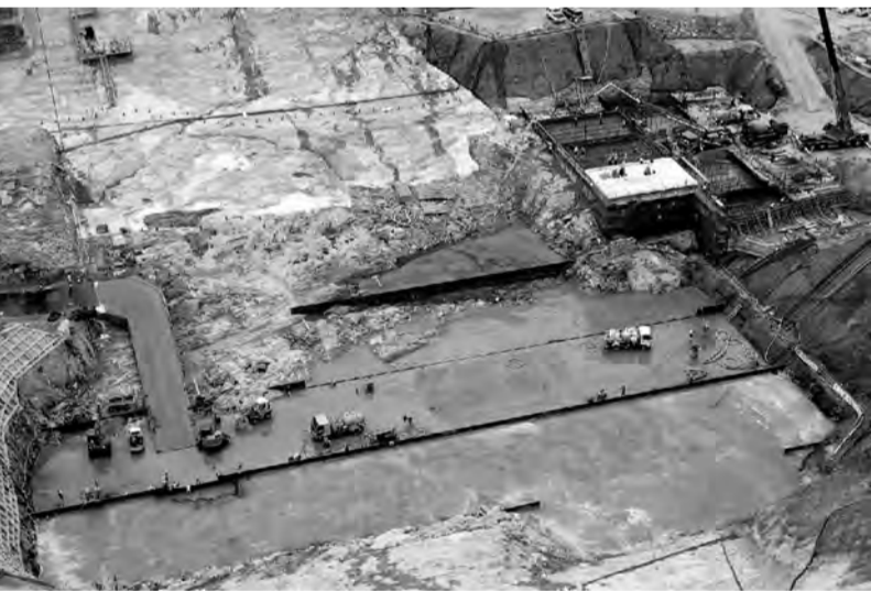
堤体コンクリート打設面
