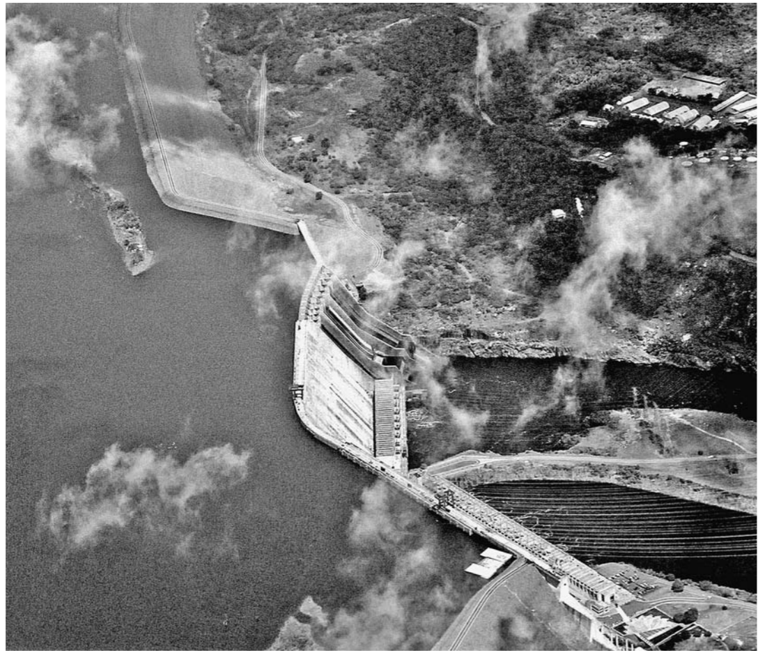
グリダム(シモン・ポリバル水力発電所)／ベネズエラ ■河川：カロニ川 ■完成：1986年 ■形式：重力式コンクリート・ロックフィル・アース ■堤高：162m ■堤頂長：7426m ■堤体積：602万6000m 3 ■貯水池容量：1350億m 3 ■発電容量：1万MW (世界第2位)
