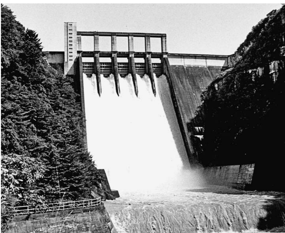
佐久間ダム 河川:天竜川 完成:1956年 形式:重力式コンクリートダム 堤高:155.2m 堤頂長:2935.5m 総貯水量:3億2685m³ 水力発電を主目的に建設され、現在、洪水調節目的を付加する再開発が進む。
