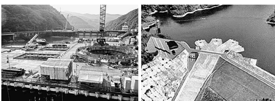
施工中の鹿野川ダム貯水池内大規模仮締切
