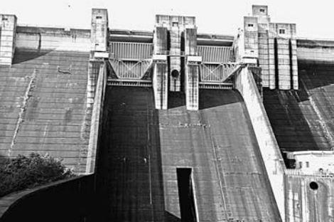
健全度調査中の野村ダム堤体下流面
