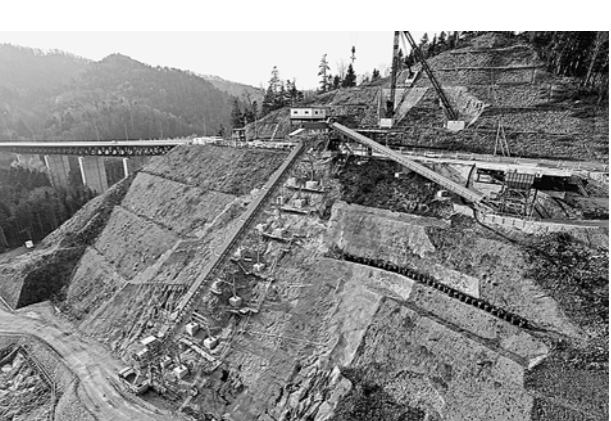
堤体右岸の急傾斜サンドイッチコンベヤー
