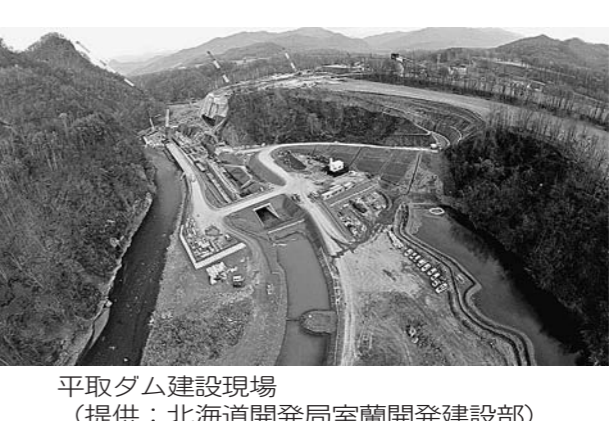
平取ダム建設現場(提供:北海道開発局室蘭開発建設部)
