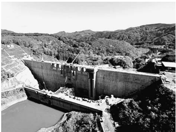
津軽ダム堤体
