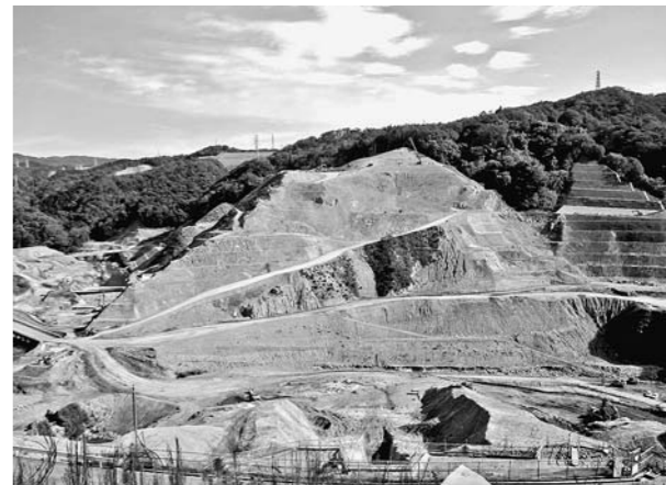
堤体左岸掘削
