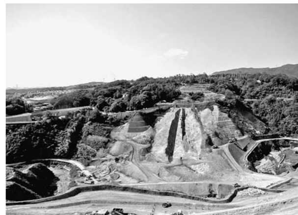
堤体右岸掘削
