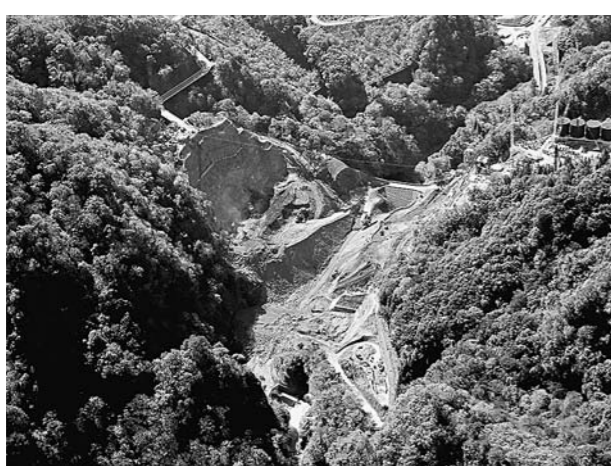
ダムサイト全景(下流から上流を望む)
