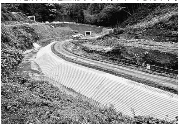
一次転流工事状況
