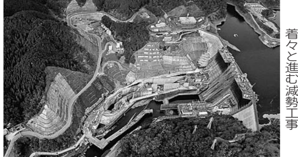
下流からダムサイトを望む
