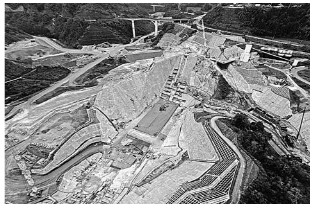
着々と工事が進む中央コア
