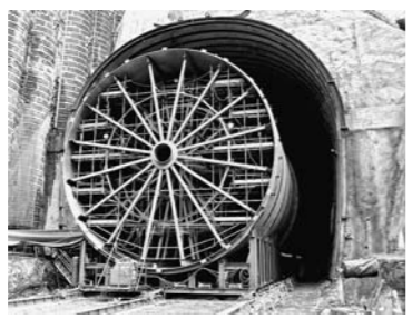
世界最大級の放流管のトンネル引き込み状況
